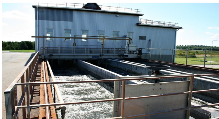
2 pav. Smėliagaudės Šiaulių nuotekų valykloje [7]
